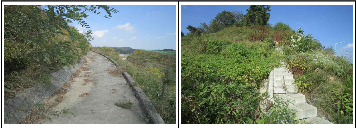
【그림 8.3.3】 배수시설 전경
