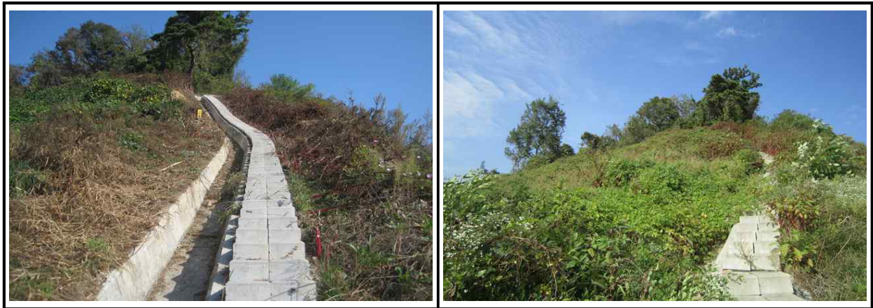
【그림 8.3.1】 상부자연사면 전경
